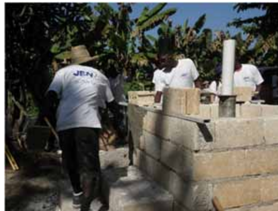
井戸の周りの塀を建設するジェンスタッフたち。
