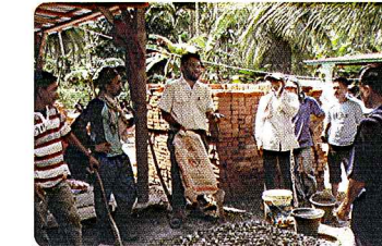
緊急支援② 巡回建設指導中に被災 者へ技術トレーニング を行うSNSスタッフ ©SNS
