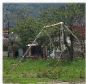
津波の圧力で支柱が曲がった公園のブランコ。津波のパワーが何える
