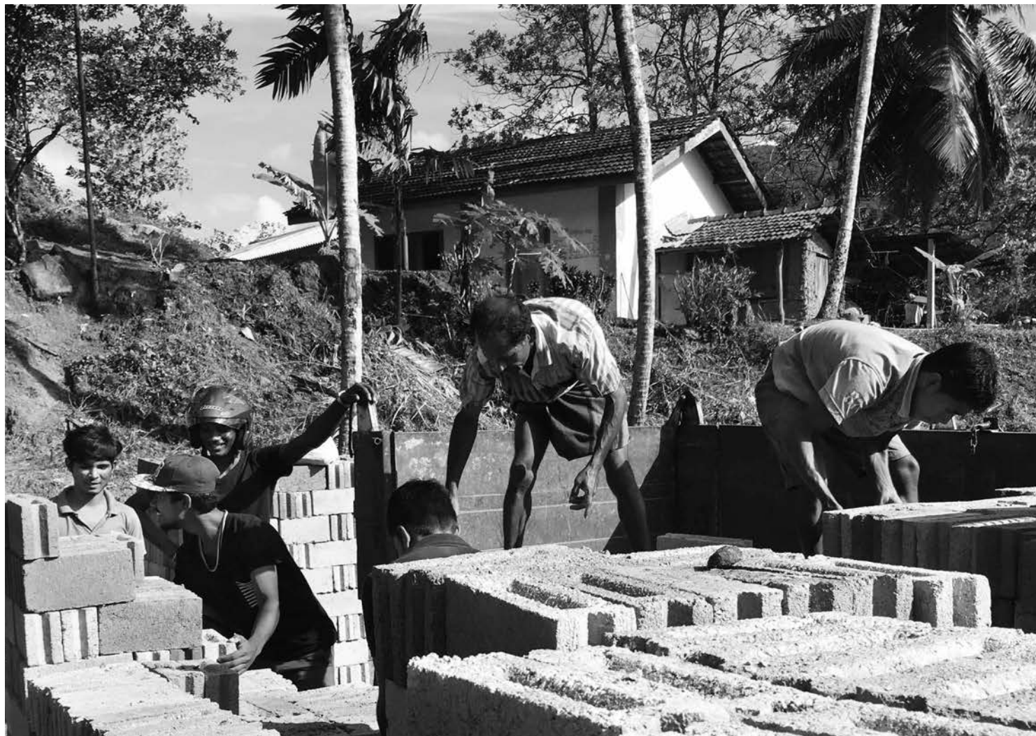
5月の洪水で被災した村の若者が、木材やブロックなど家を建てる資材の運搬に、総出で協力してくれました。(スリランカ・ラトゥナブラ県)
