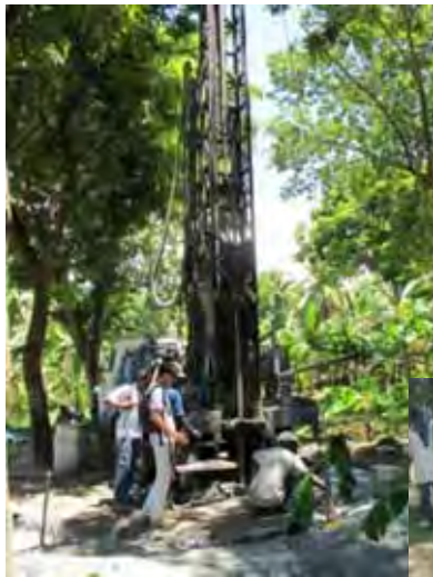
(左)トラックではるばる運んだ重機を使って井戸の掘削
