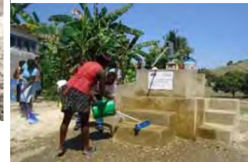
土台の高さを上げることで、大雨による井戸への浸水や井戸水の汚染を防ぎます。
