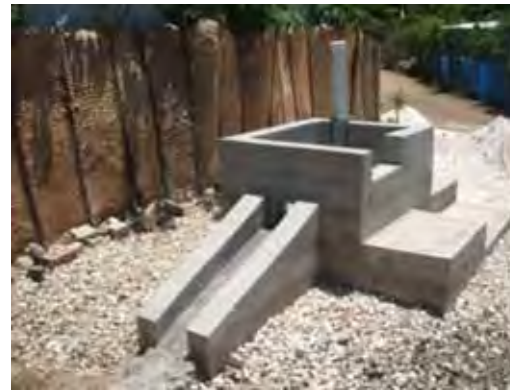
土台の高さを上げることで、大雨による井戸への浸水や井戸水の汚染を防ぎます。
