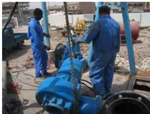
下水ポンプ設備の修復作業 Rehabilitation of sewage pump facilities
