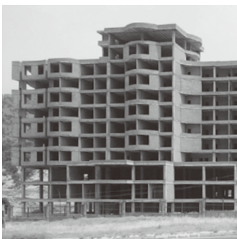
2016年夏の同じ建物。建築工事が再開し、もう避難民の姿はありません。
