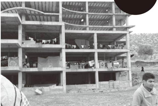
2014年冬には、工事中の建物で避難生活をおくっていた人びと
