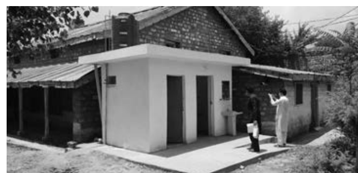
改修後のトイレと手洗い所：パラチナール市 (KP州)にある病院
