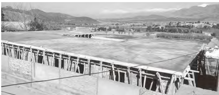
建設中の女子中学校。屋根にコンクリートを打ち込む作業をしたときの様子
