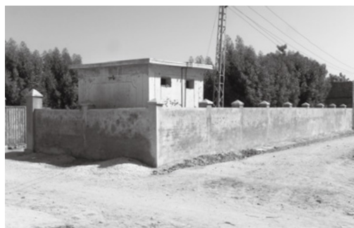
外壁の工事が終了
