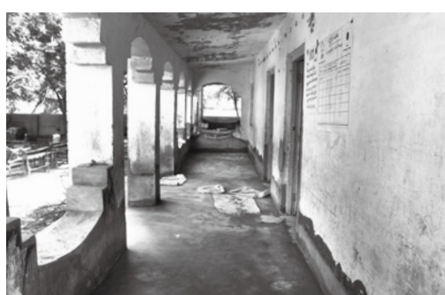
浸水した校舎1階を再建工事中
