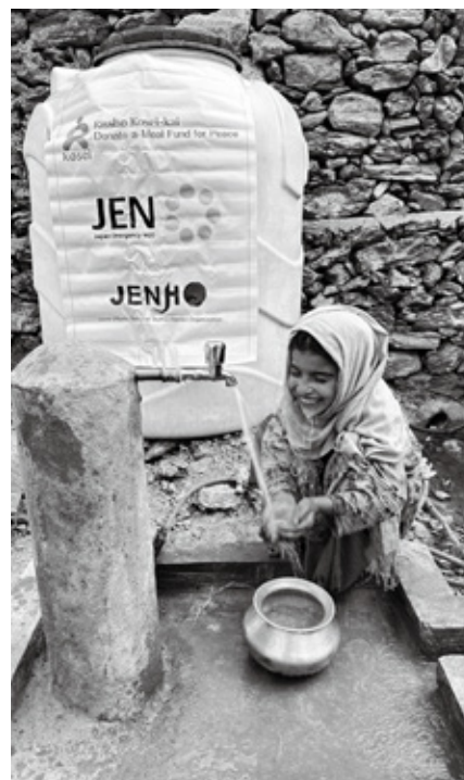
完成した給水所。蛇口をひねると勢いよく水が飛び出した。
